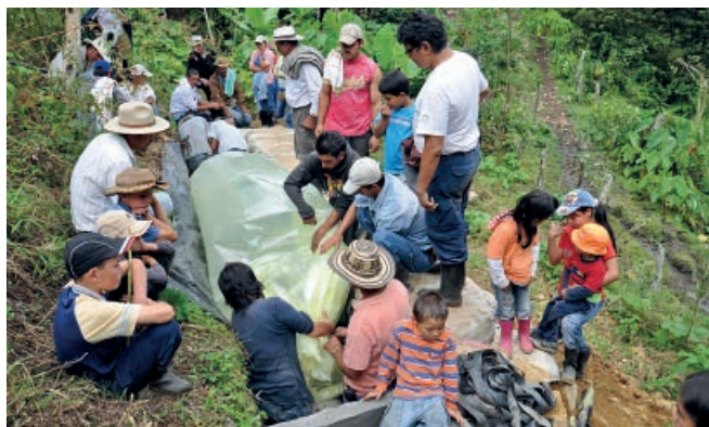
Instalación de un biodigestor durante capacitación en la finca de un integrante del GAL. 📷 Yuly C. Zapata
