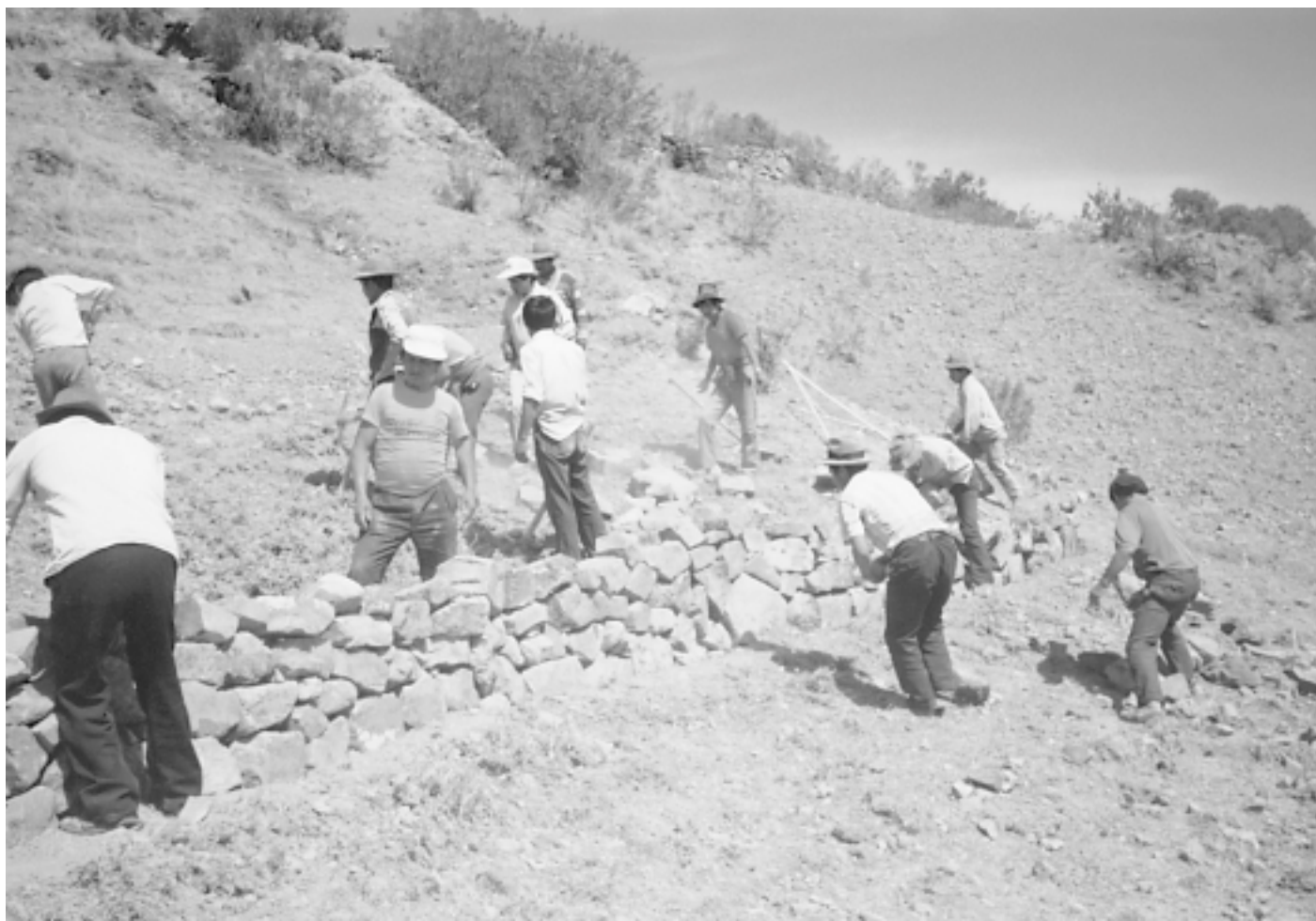
Construcción de terrazas de formación lenta a través de ayni . Comunidad de Chullpa K'asa
