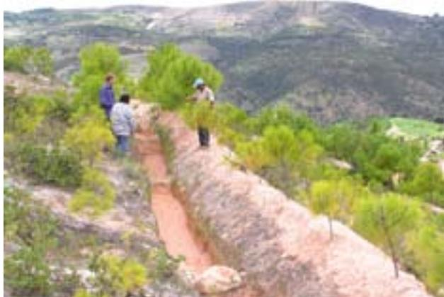
Zanja trinchera con reforestación de pinos (*Pinus oaxacana*) en áreas erosionadas
