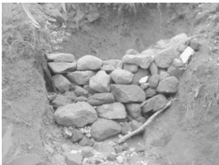
Estabilización de cárcavas
