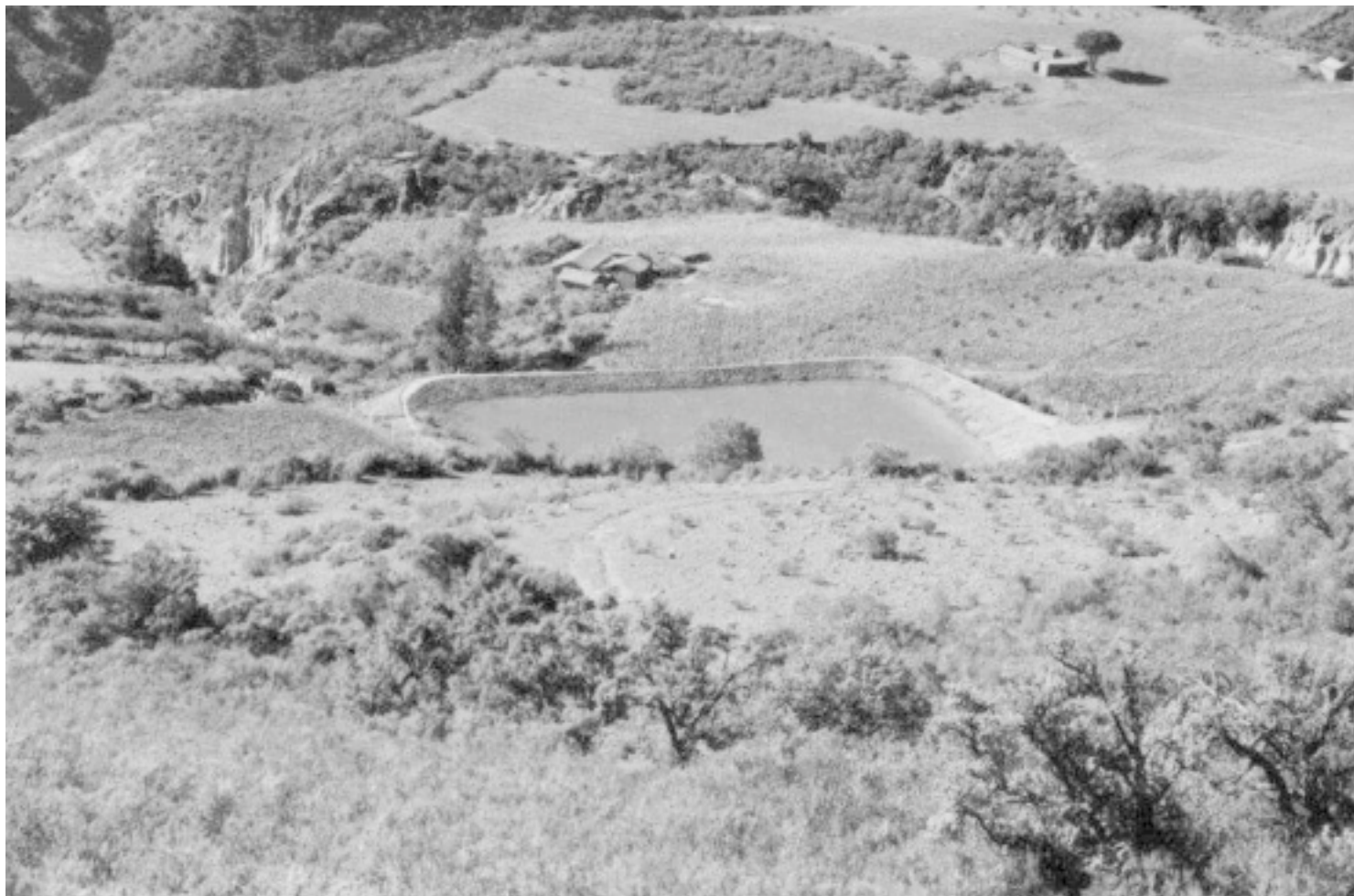
Un 'atajado' construido en ladera de fuerte pendiente
