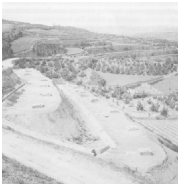
Cuando está lloviendo, los canales pueden conducir agua colectada desde el camino y las pendientes de la colina hasta las dos hileras de tanques. El agua de tanque se utiliza para regar cultivos y árboles de las tierras de la parte inferior. En la parte inferior derecha, la tierra está cubierta con láminas de plástico para prevenir la erosión y elevar la temperatura del suelo
