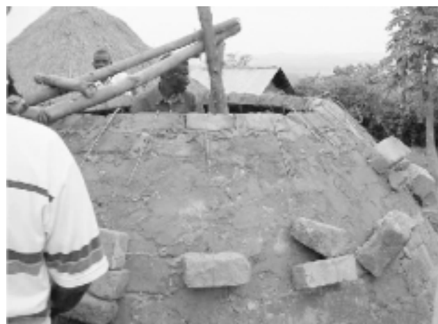
Construcción de un tanque esférico en el distrito Mbarara, Uganda
